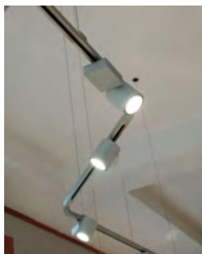
3-Phasen Stromschienensysteme
